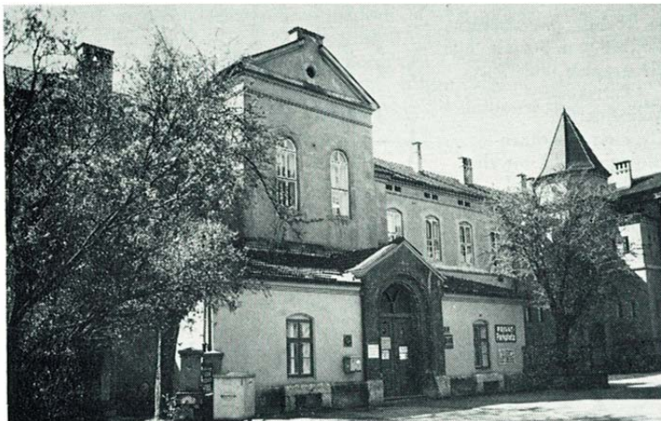
Ab.3: Schulgebäude in der Michael-Gaismair-Straße 1
